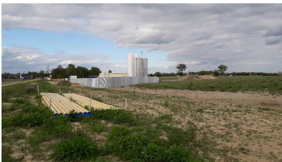
Fot. 3. Stacja LNG – w budowie przy ul. Przemysłowej, w bezpośrednim sąsiedztwie obszaru opracowania
