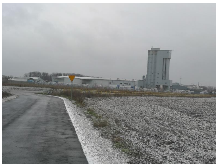
Zabudowa produkcyjno- usługowa na dz. nr 232/11 (KREISEL Technika budowlana sp. z o.o.)
