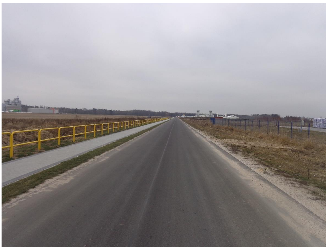
Fot. 9 Obszar opracowania – wewnętrzna droga dojazdowa do zakładu Źródło: Fotografia własna
